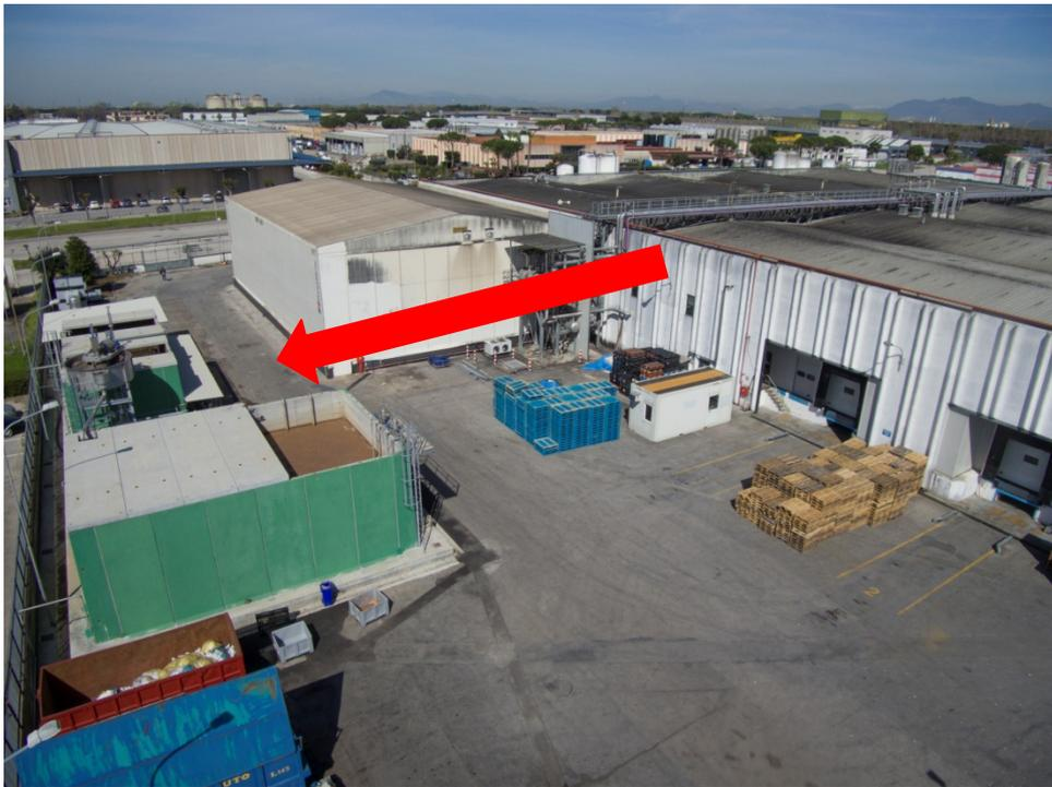
*È stato realizzato un impianto con una grande vasca di accumulo/omogeneizzazione per poter gestire le punte soprattutto durante i lavaggi delle apparecchiature nei fine settimana; l'impianto è costituito da pretrattamenti di grigliatura con luce 1 mm, vasca di accumulo, DAF, ossidazione con tecnologia MBR, linea fanghi con nastropressa.*
